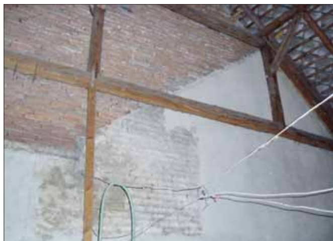
Obr. 18 Posuzovaná štítová zeď uvnitř objektu
