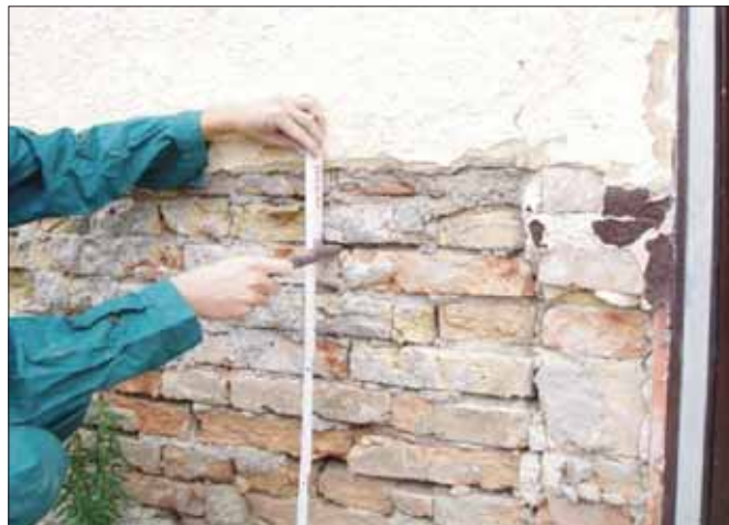
Obr. 20 Odběr vzorku z obvodové nosné zdi uličního traktu
