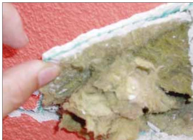
Obr. 11 Odběr vzorků tepelné izolace
