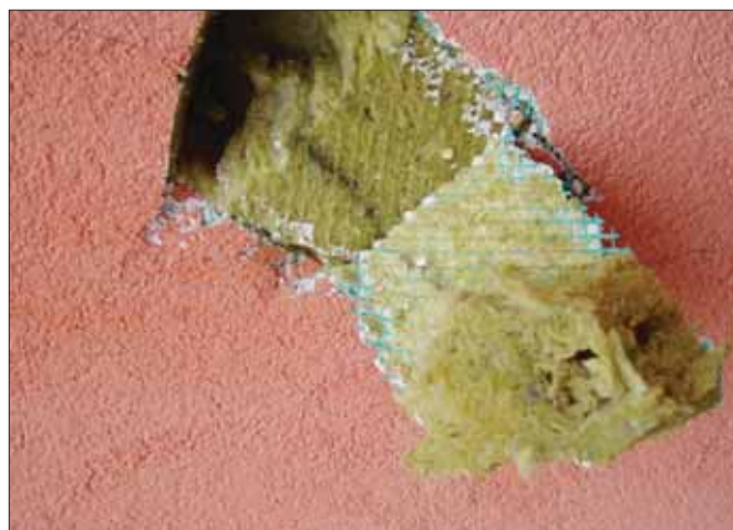
Obr. 9 Odběr vzorků zateplovacího systému se šterkou
