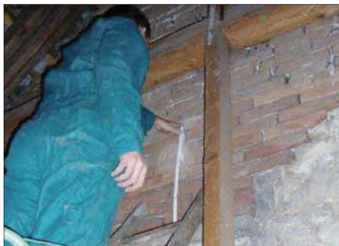
Obr. 19 Odběr vzorku zdicího materiálu z předmětné štítové zdi
