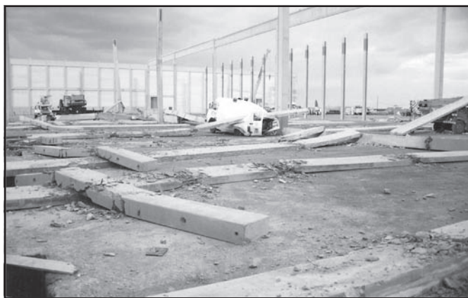
Obr. 3 Pohled na havarovanou přístavbu halového komplexu.
