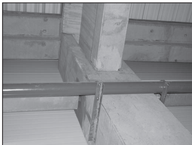
Obr. 1 Pohled na uložení vazníku na krajní sloup v původní části komplexu hal.
