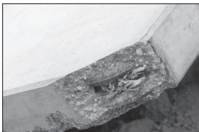
Obr. 6 Detail vazníku, u něhož v otvoru pro kotevní trn byla ponechána dřevěná lať.
