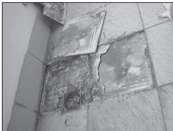
Obr. 9 Nekompaktní spárování dlažby balkonu.
